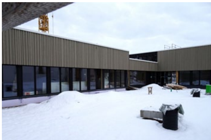
Neues Gemeindezentrum, 15. Januar 2019
