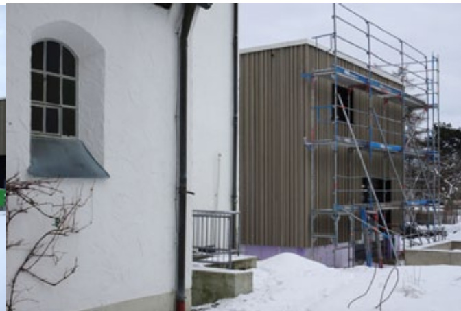
Neues Gemeindezentrum, 15. Januar 2019
