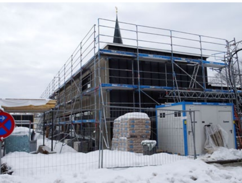
Neues Gemeindezentrum, 15. Januar 2019
